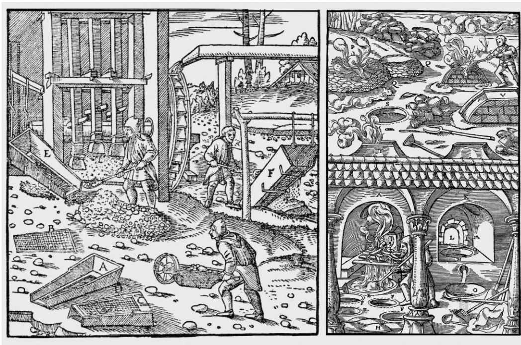
Rysunek 5 7 . Proces upłynniania złoża ołowiu oraz proces przetapiania ołowiu w piecu ceglany (wizualizacja wg. G. Agricoli z XV w.) (Agricola 1950).
